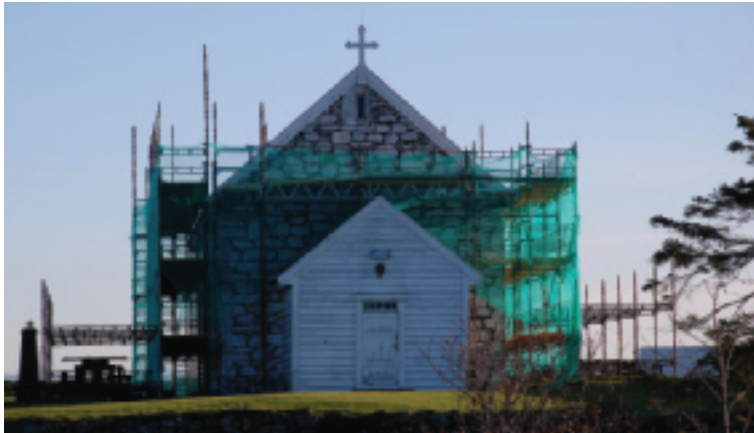
avhogging av utvendig murpuss, høsten 2008
