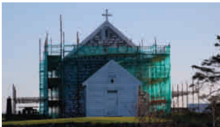
avhogging av utvendig murpuss, høsten 2008
