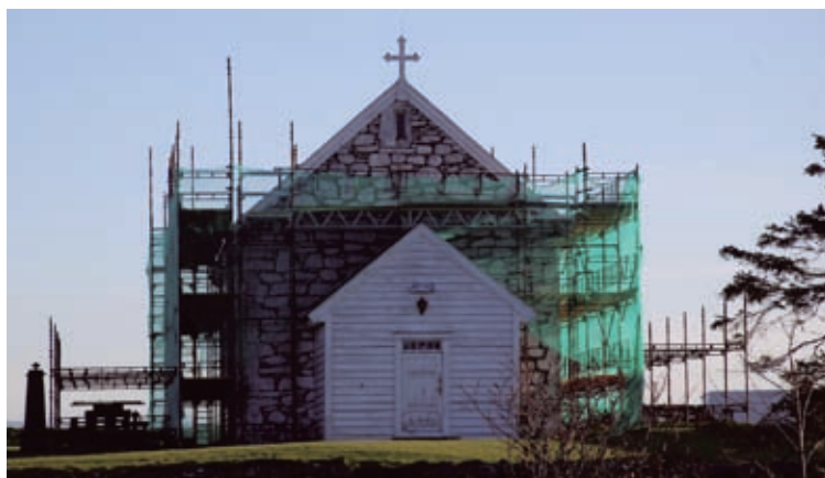
avhogging av utvendig murpuss, høsten 2008
